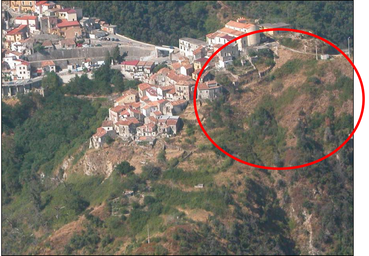
Foto 8: Zona franosa profonda SELL. 15 (prima dei lavori di consolidamento in corso)
