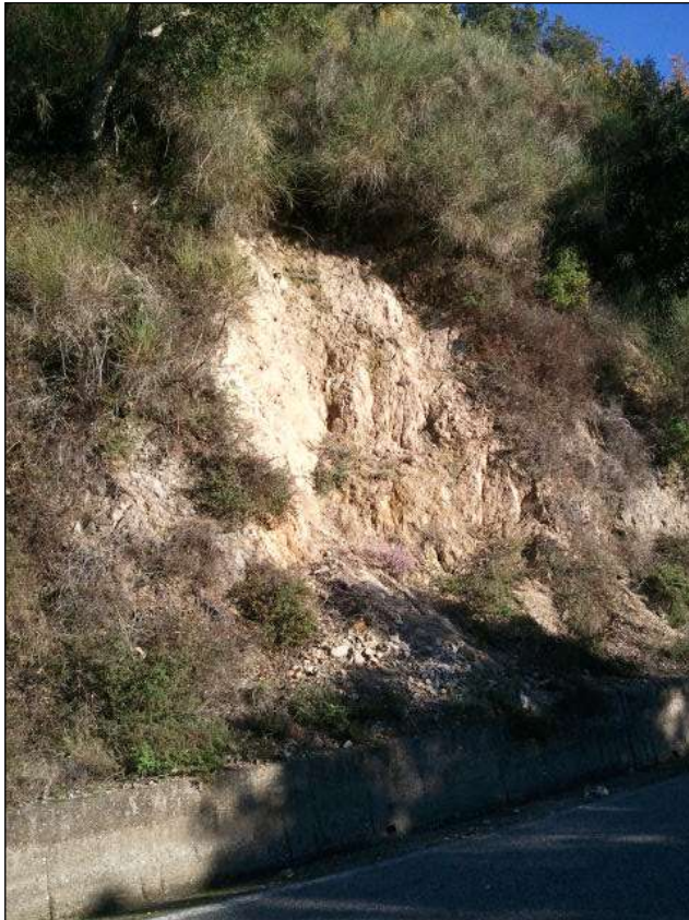
Foto 19: Frana per crollo nei graniti lungo la strada provinciale Bivio Arsanise - Sellia
